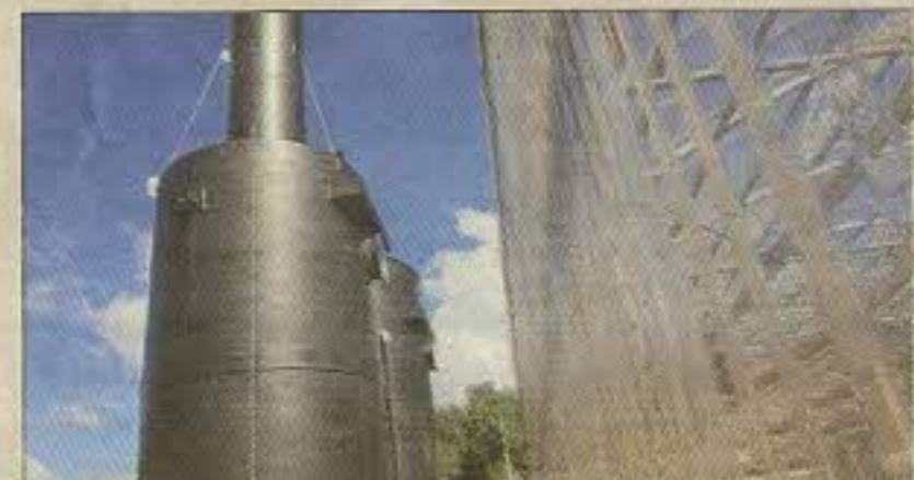
Les ajouts à l'installation comprennent un module de désodorisation avec un testeur olfactif efficace et une cheminée volontairement plus haute que la norme. (Photo J. O.)
